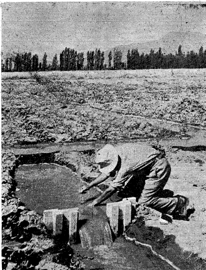
Foto N° 1: Vertedero de sección rectangular utilizado en estos ensayos. El "gasto" se está midiendo en la forma usual, sobre una estaca sumergida, a nivel con el umbral del vertedero.
